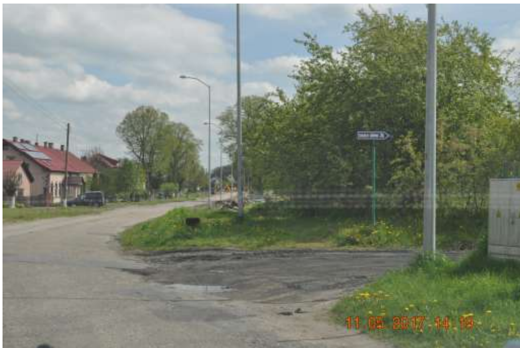
Fot. 4 Skrzyżowanie drogi powiatowej z drogą gminną (stan z 11.05.2017 r.)
