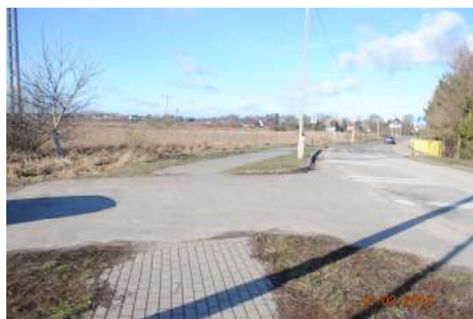
Fot. 2 Zjazd bitumiczny na drogę z płyt betonowych przewidziany do likwidacji i zabudowy projektowanym chodnikiem
