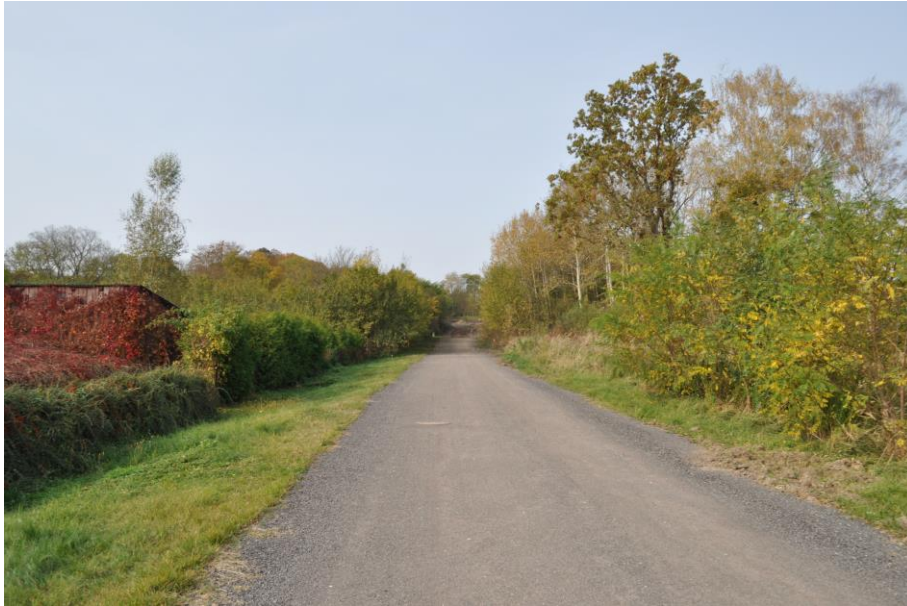
Fot. 6 Istniejąca droga o nawierzchni gruntowej ulepszona destruktem bitumicznym (fragment na którym przewiduje się budowę miejsc postojowych po stronie lewej niniejszej fotografii)
