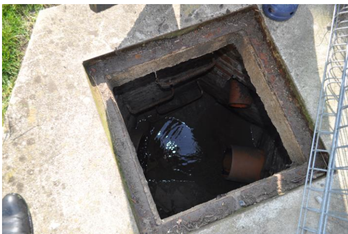
Fot. 4 Istniejąca studnia rewizyjna murowana, wchodząca w system odprowadzenia wód deszczowych do Odry Zachodniej poprzez działki o nr ewid. 189 i 44 z obrębu Siadło Dolne.
