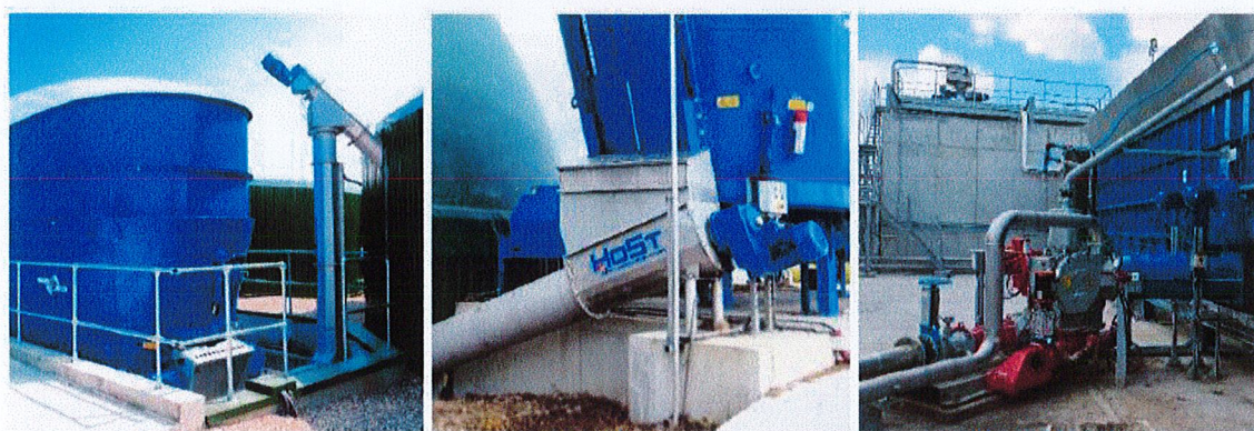
Rys. 6b. Integracja zasobnika substratów sypkich z komorą fermentacyjną.
